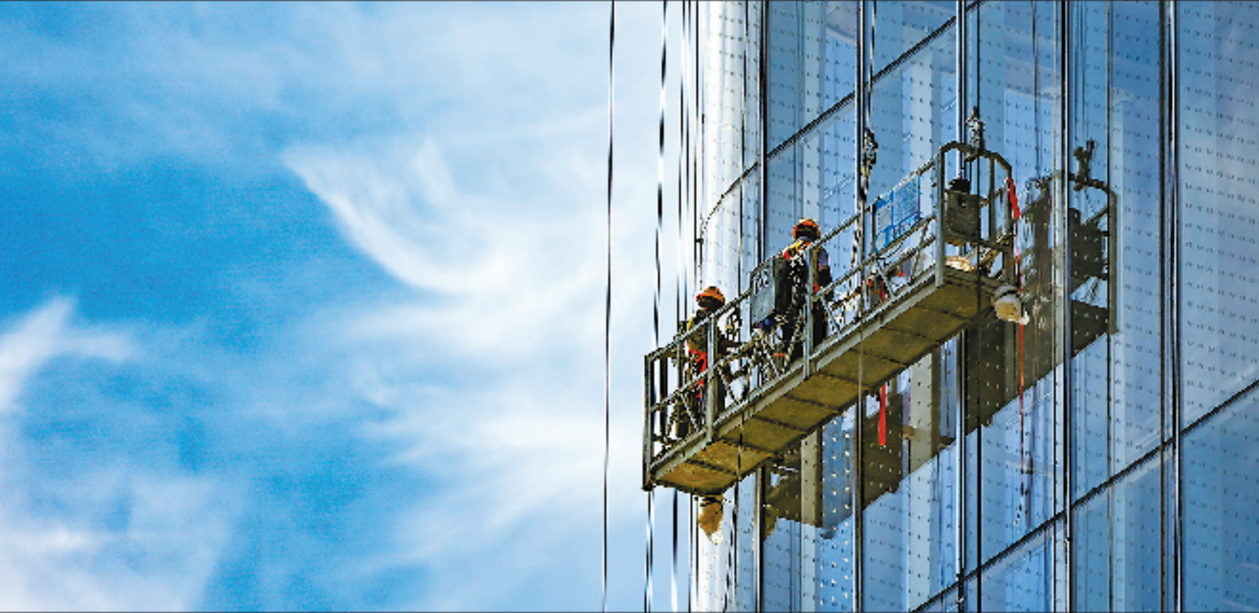
7月2日,浙江省全民健身中心项目建设现场,工人在高空吊篮上安装幕墙玻璃。该项目是重点民生工程,为确保工期,建设团队采取错峰施工,避开午间高温时段,同时配备防暑降温物资,保障作业安全。 本报记者 董旭明 摄
