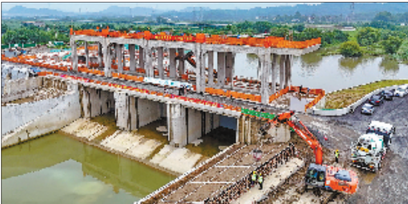
工人正在浇筑南湖枢纽最后一段防浪墙。
