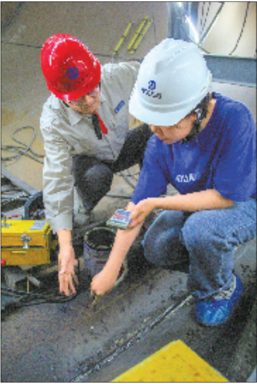
记者(右)在天台抽水蓄能电站监理部副总监郭世忠指导下检测管道焊接质量。 本报记者 杨群 摄
