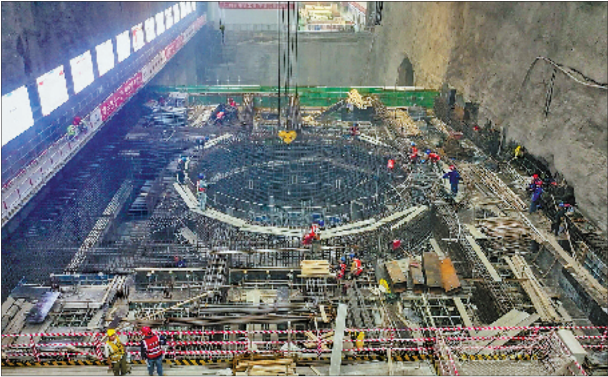
天台抽水蓄能电站正在进行3号机组发电机层混凝土备仓。
