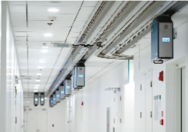
轨道小车在医院的吊顶穿行,可以运送10公斤以内的药品、耗材等。
