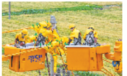
国网台州市黄岩区供电公司工作人员在进行配网不停电作业。 冯静 摄
