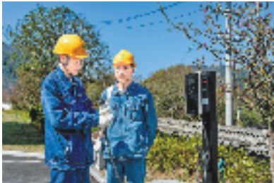
国网绍兴供电公司员工仔细检查充电桩线是否存在磨损、老化迹象，充电桩卡扣有无异常。 王星欣 摄
