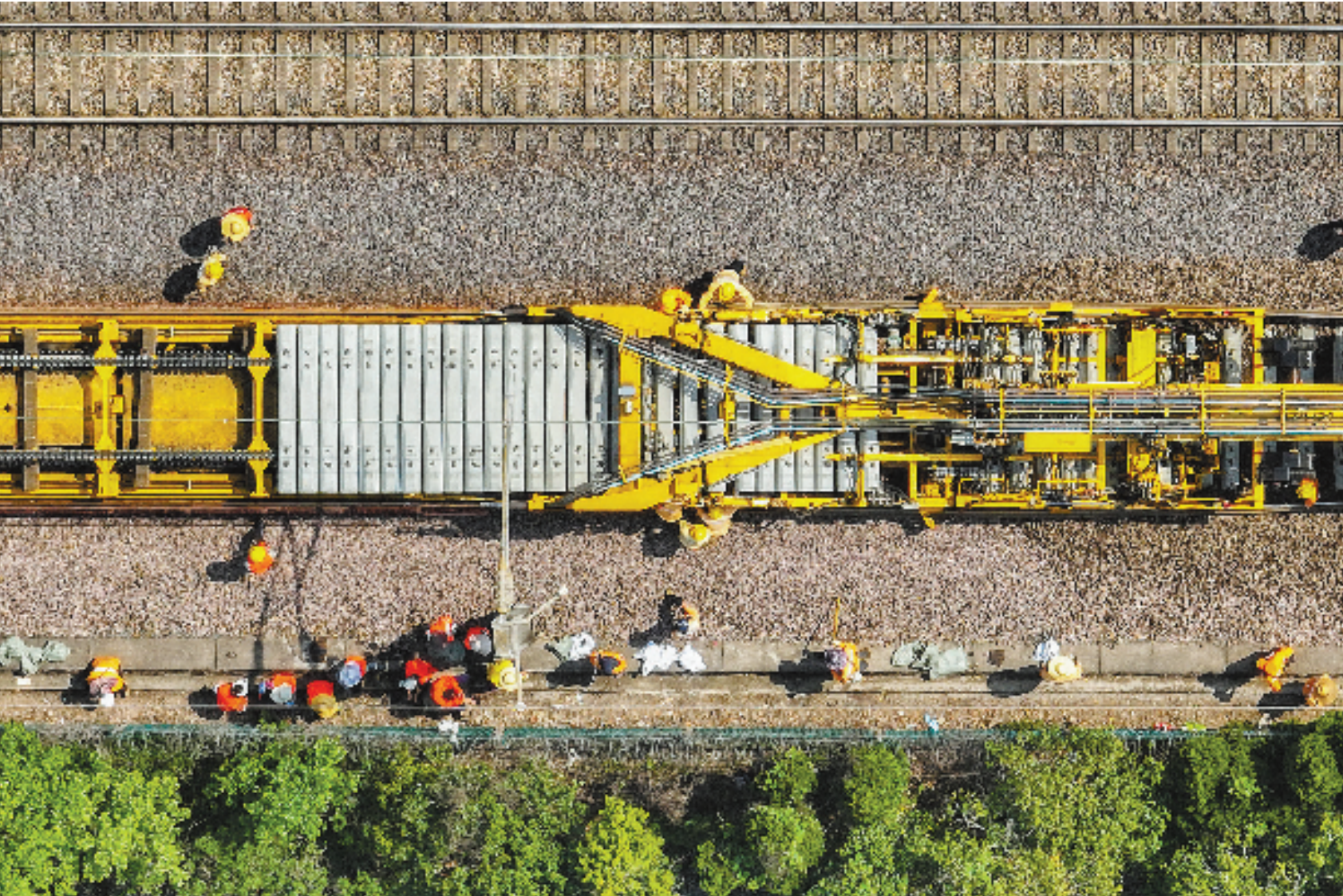
4月10日,在沪昆铁路线上行线金华白龙桥站至金华普速场区段,配合大修列车、配砟车、捣固车等大型机械作业,工作人员正在对该路段进行大修换枕施工,以进一步提高铁路线路设备质量,提升列车运行平稳性和舒适度。 本报记者 金思成 通讯员 时宽兵 梅文涛 文/摄
