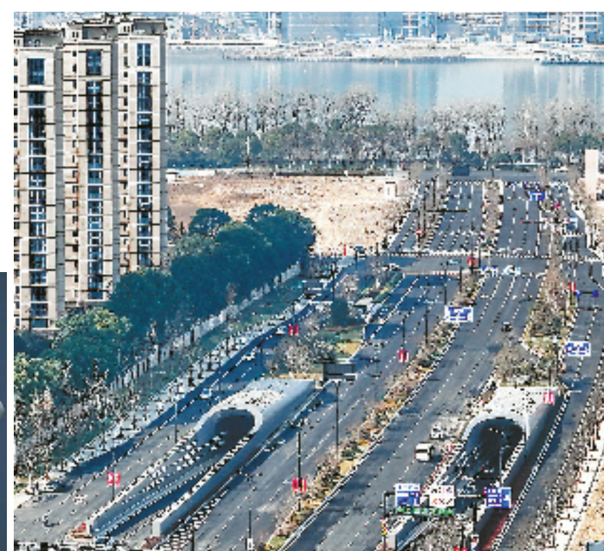
秦望隧道江南出入口。
