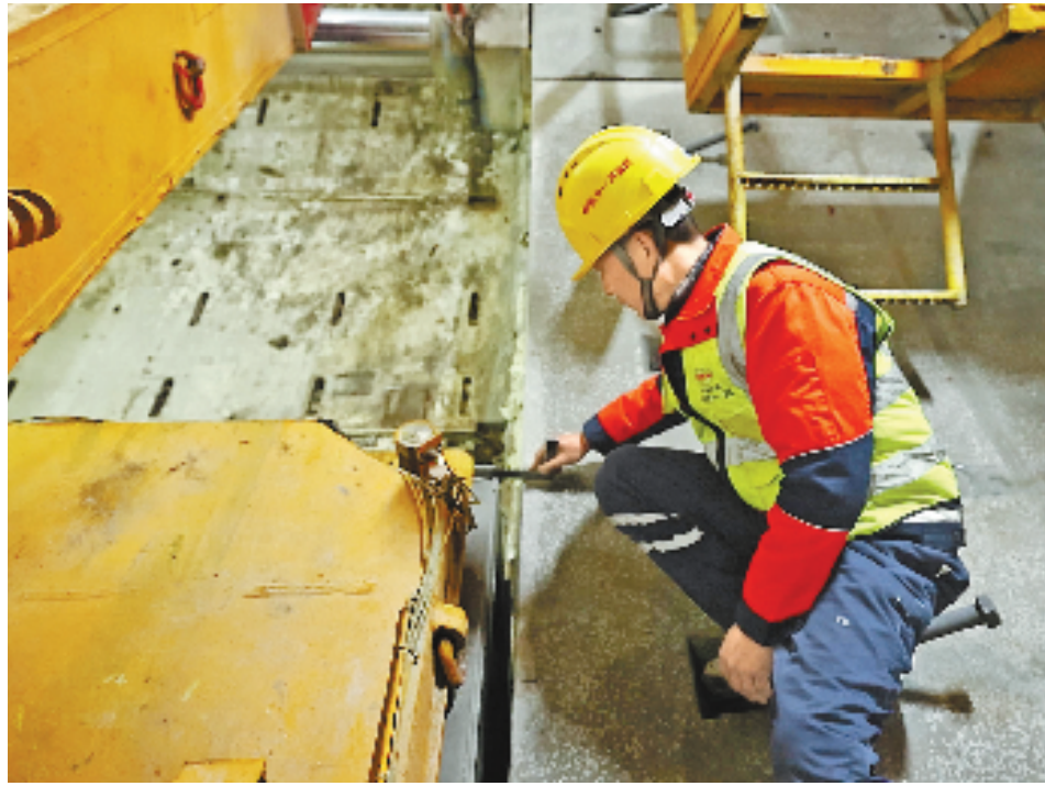
曹恒军在测量管片和管片吊机的间距。
