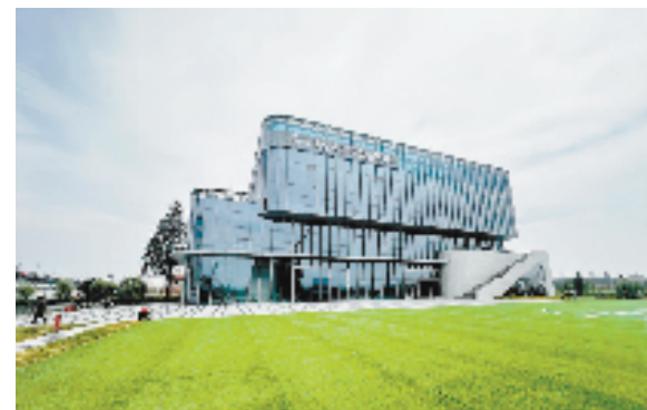
绍兴低空经济综合服务中心
