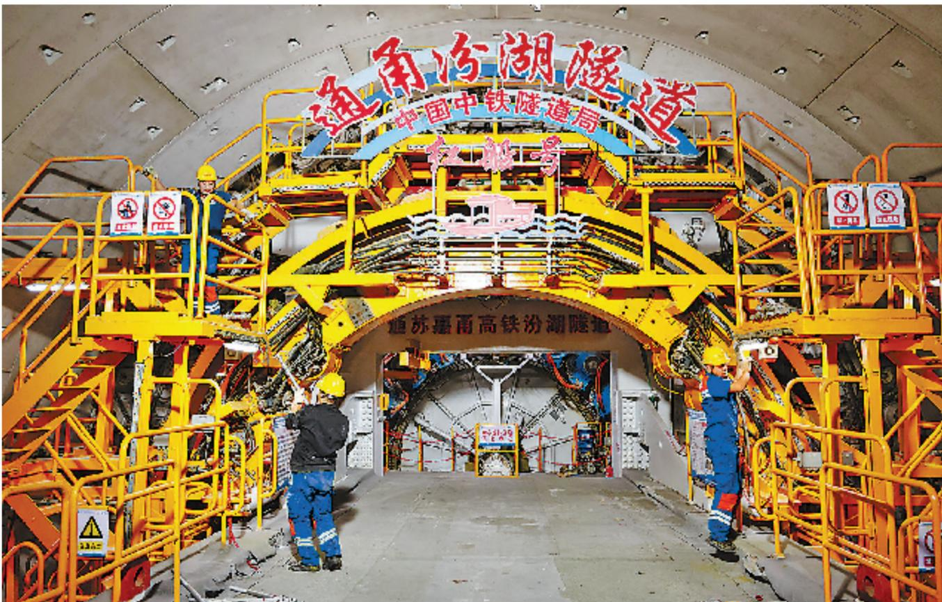
1月9日,嘉善陶庄,“红船号”盾构机在汾湖湖底稳稳转动,驱动大型刀盘向苏州方向掘进。通甬汾湖隧道位于嘉善县和苏州市吴江区交界处,是通苏嘉甬高铁嘉兴段的一个控制性工程,隧道全长3732米,其中浙江境内2228.59米。目前浙江段掘进长度已过半,预计到明年4月,该隧道将全线贯通。
