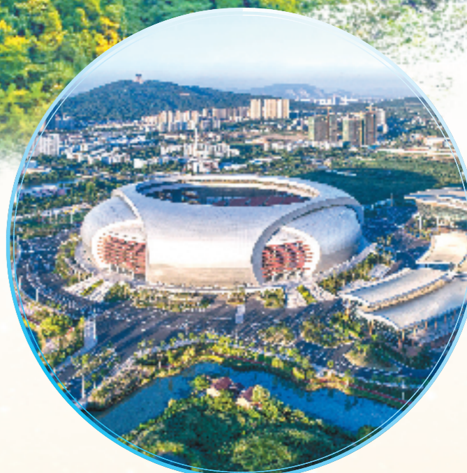
湖州市南太湖奥体中心工程
