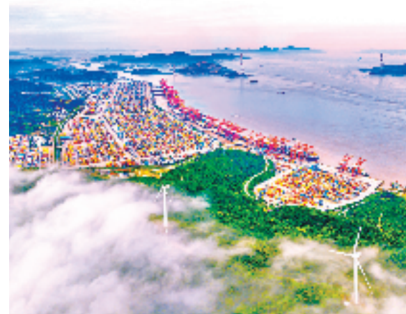
宁波舟山港穿山港区 沈颖俊 摄
