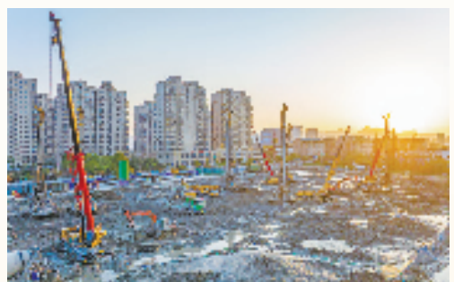
城东街道新城智谷一期项目施工现场
