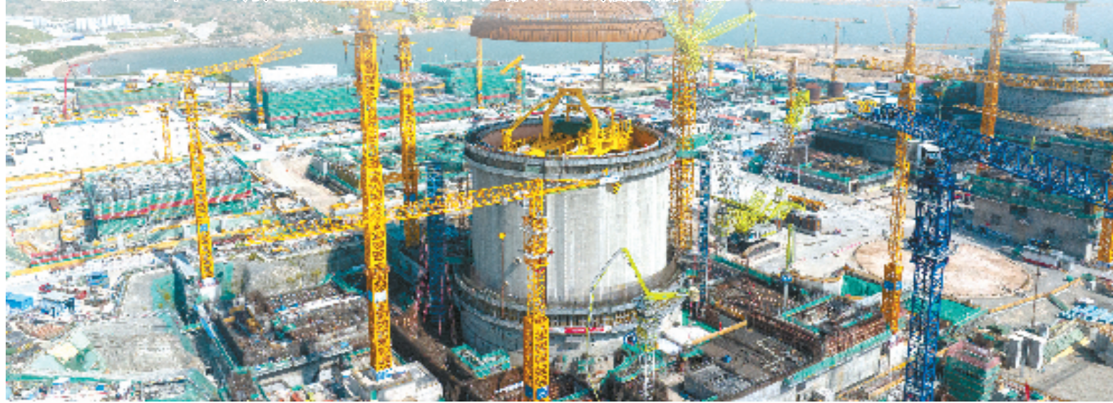
三澳核电建设施工现场
