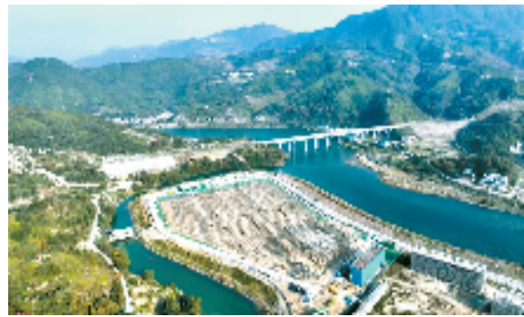
华润饮料温州生产基地坐落于文成县巨屿镇白鹭洲水经济产业园内。
