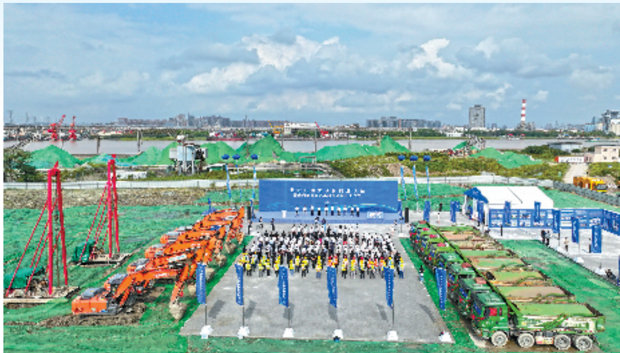
吉利新能源汽车总部项目在甬江科创区北仑片区开工
