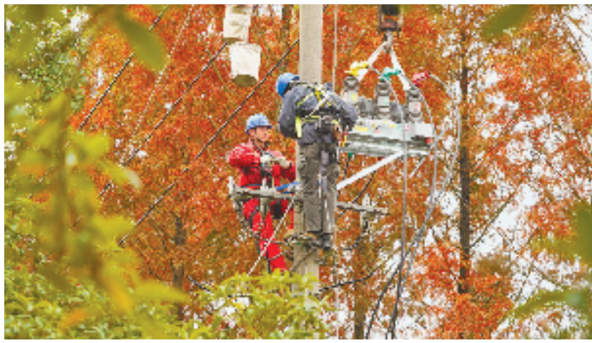
12月5日,国网德清县供电公司工作人员正在对10千伏线路进行作业,提升电网迎峰度冬保供能力。
