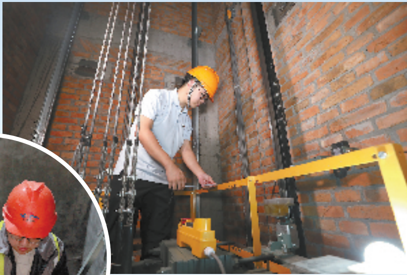
华光城小区电梯更新验收现场
