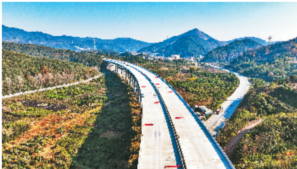
柯诸高速中村水库大桥
