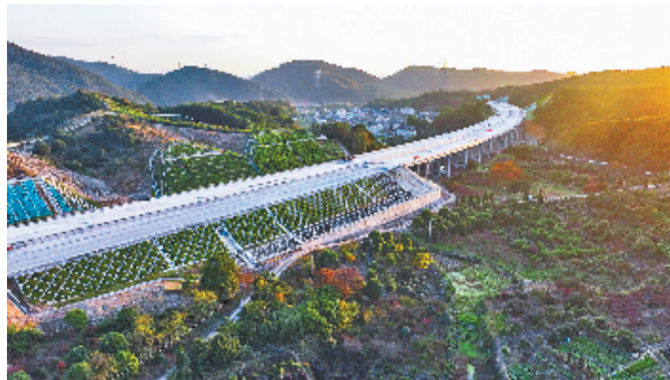
柯诸高速琴坞大桥
