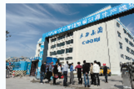
工程建设项目分期验收现场
