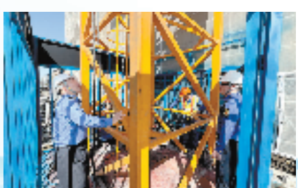
第三方辅助服务机构对安置房地块项目起重机械安全使用情况进行检测
