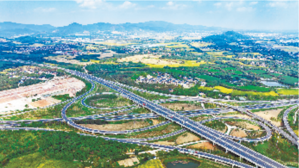
杭州绕城西复线径山枢纽
