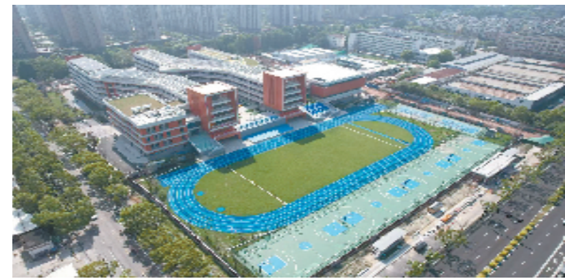
杭州市临平区临平第二小学建设项目 (图片由中交三公局华东公司提供)
