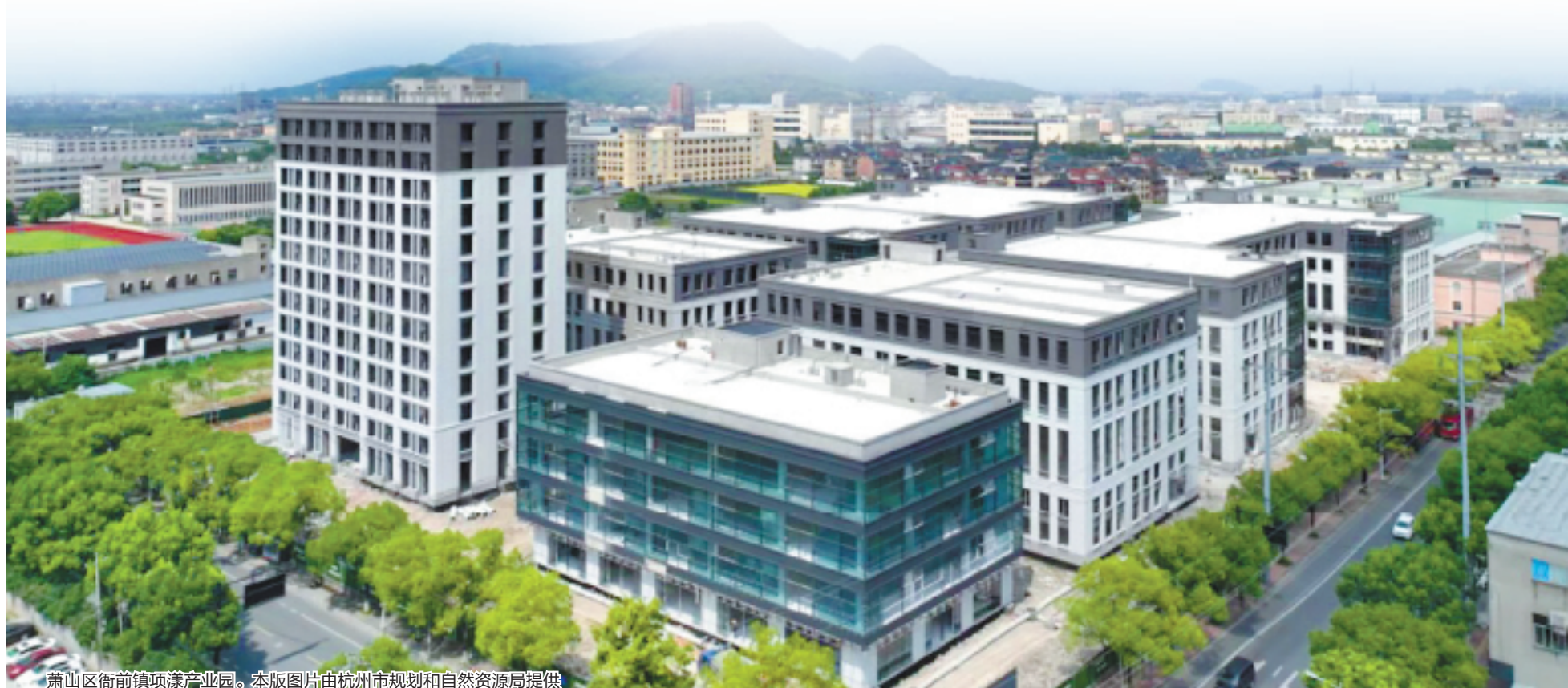
萧山区衙前镇项漾产业园。本版图片由杭州市规划和自然资源局提供
