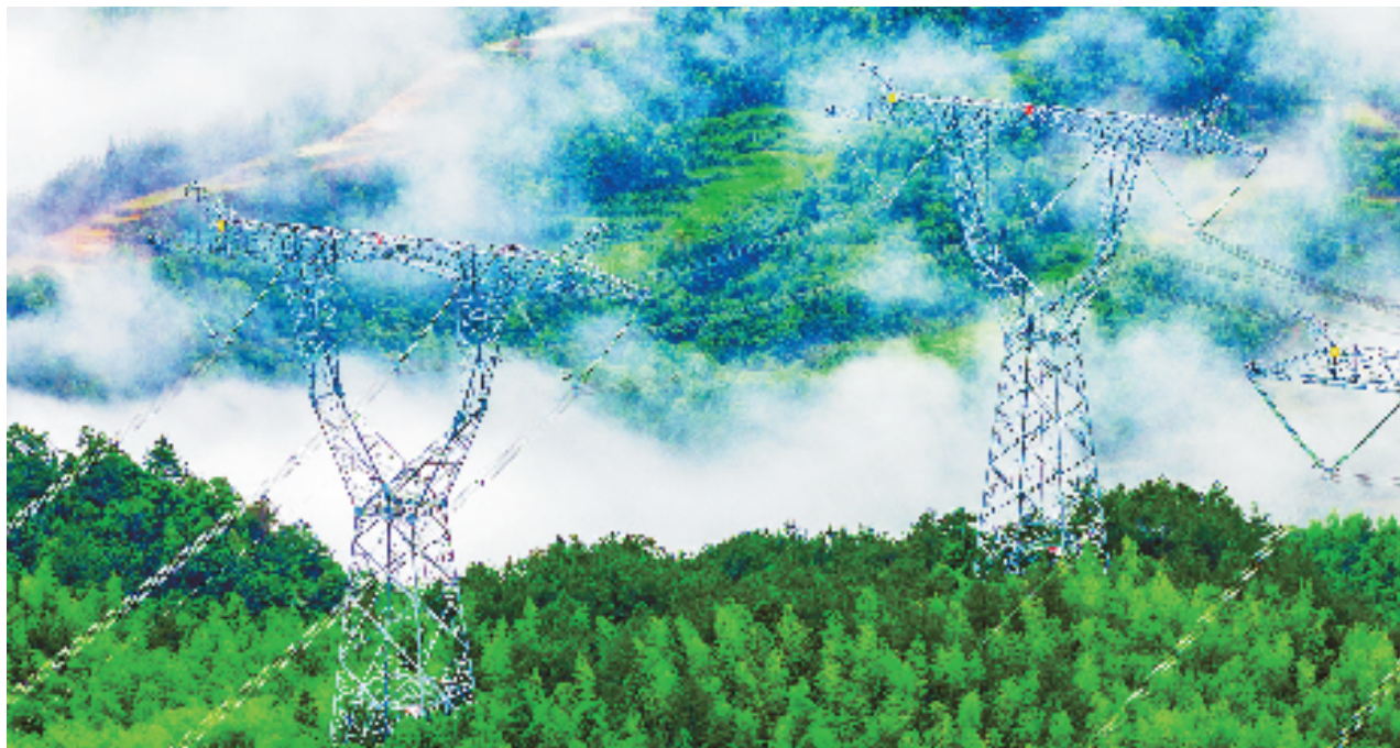
藏在云端之上的浙北—福州1000千伏特高压交流输电工程线路。
