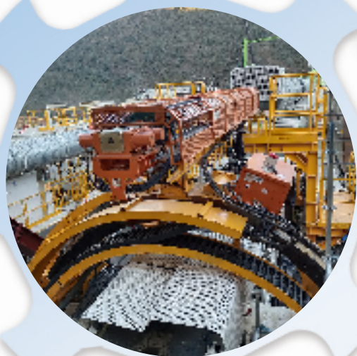
海聚科技创新开发的TBM液压超前钻机引领盾构机穿越岩层，一路向前。
