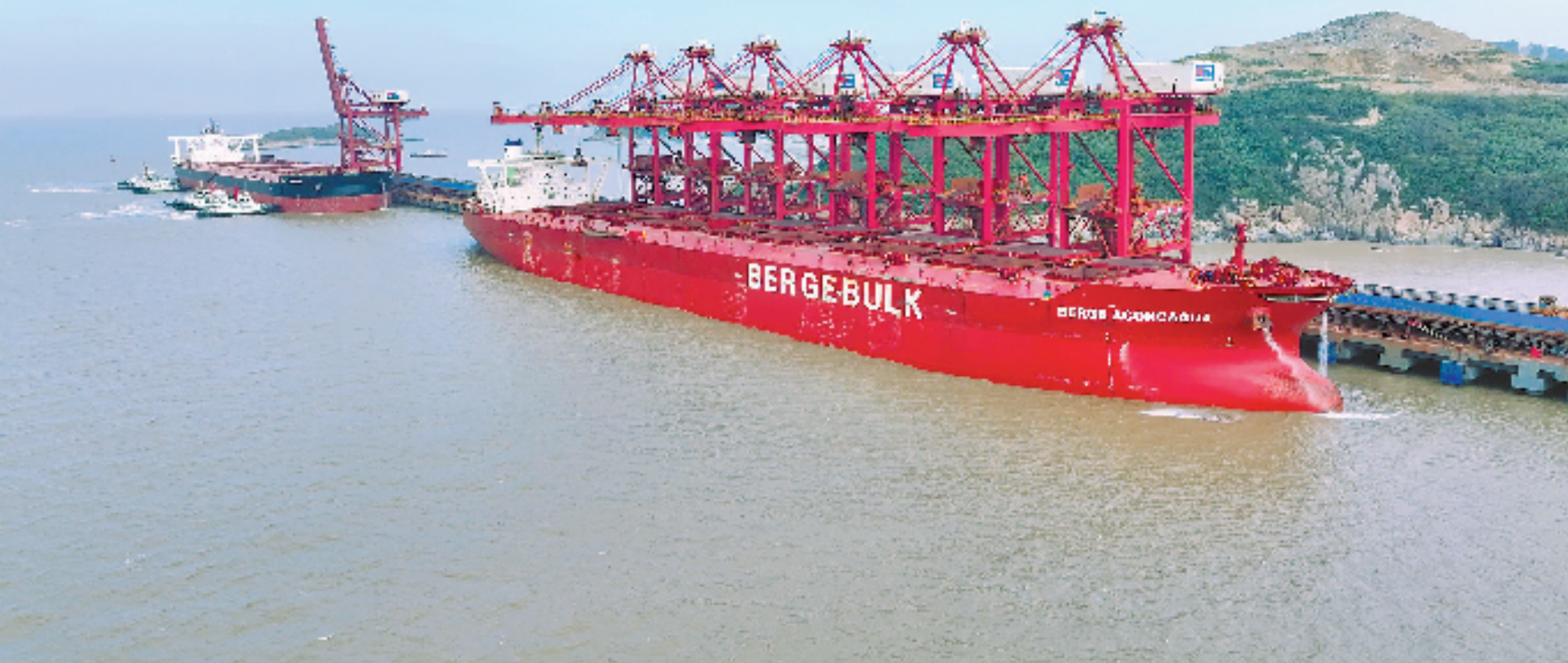
两艘40万吨世界最大矿船同时在鼠浪湖码头靠泊接卸。
