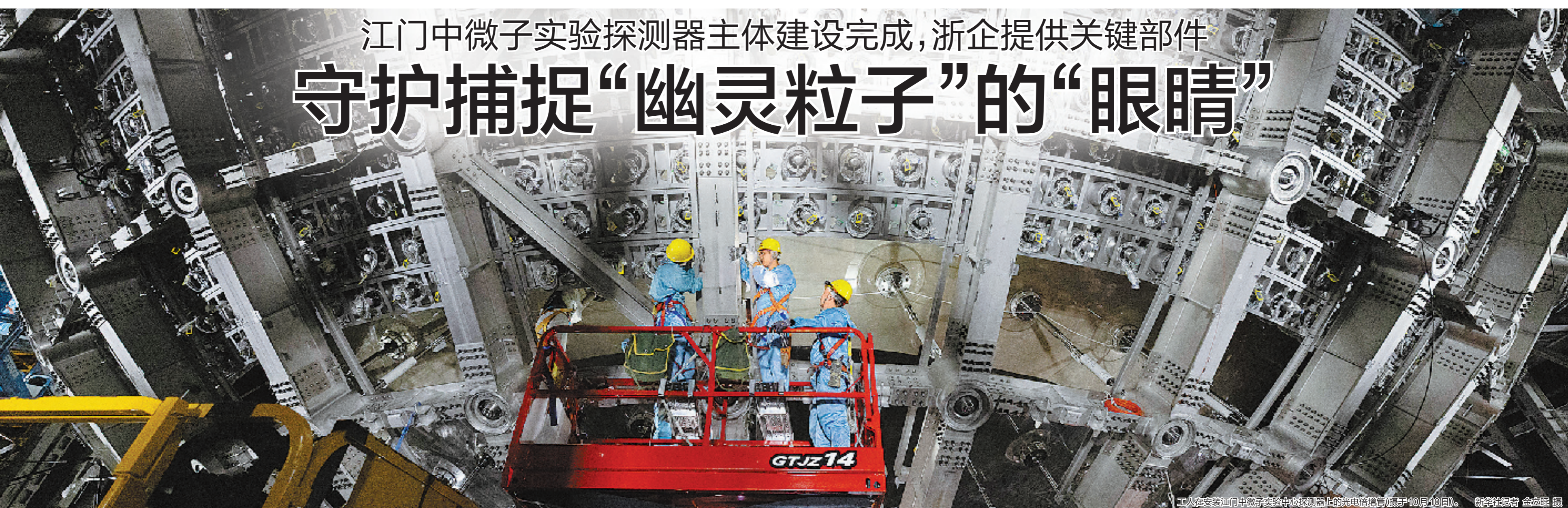
工人在安装江门中微子实验中8层探测器上的光电倍增管(摄于10月10日)。(新华社记者 金成摄)
