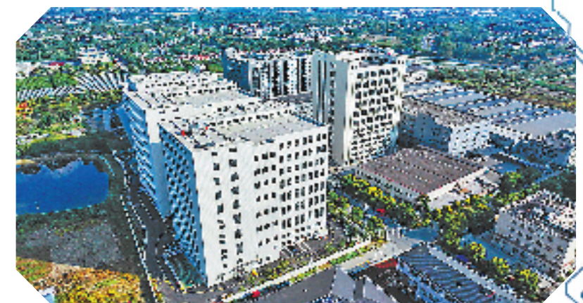
洲泉镇数字经济产业园
