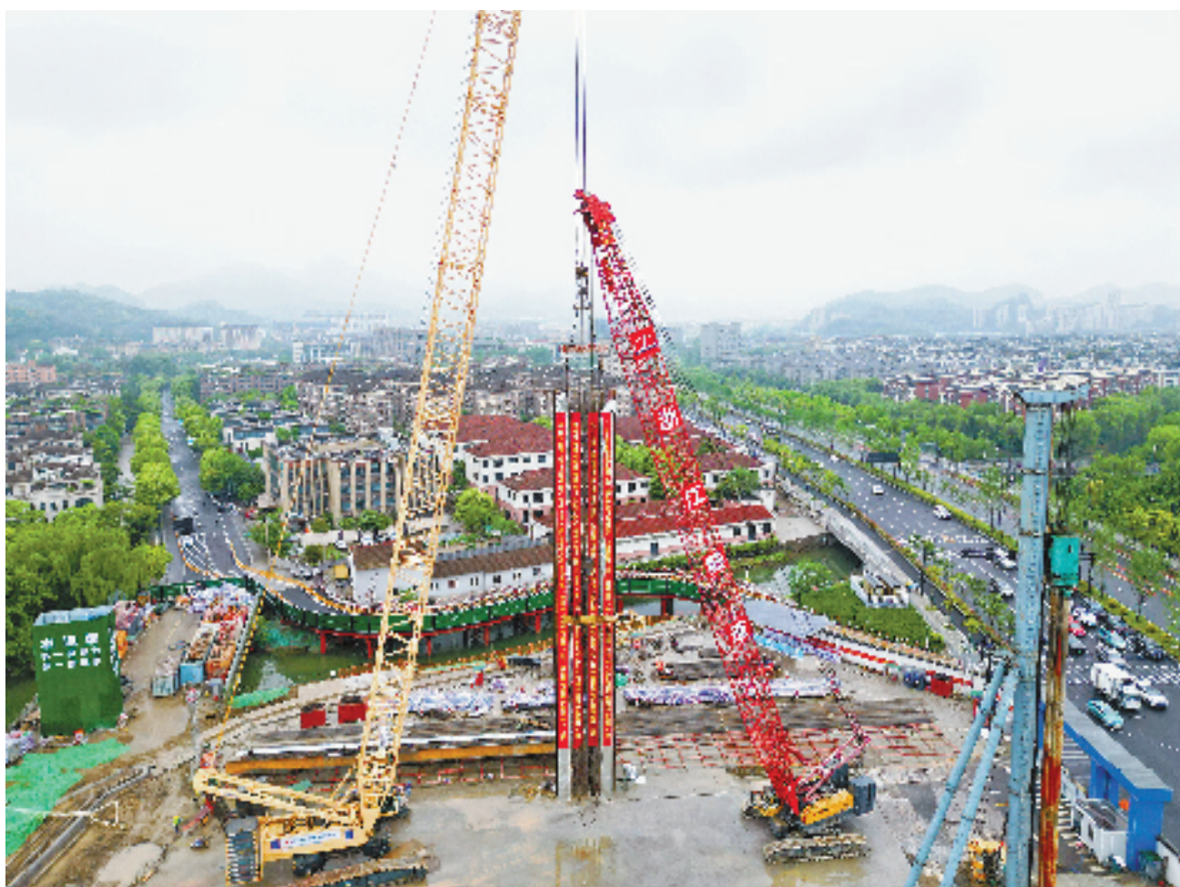
图为扩大杭嘉湖南排后续西部通道工程的施工现场。
