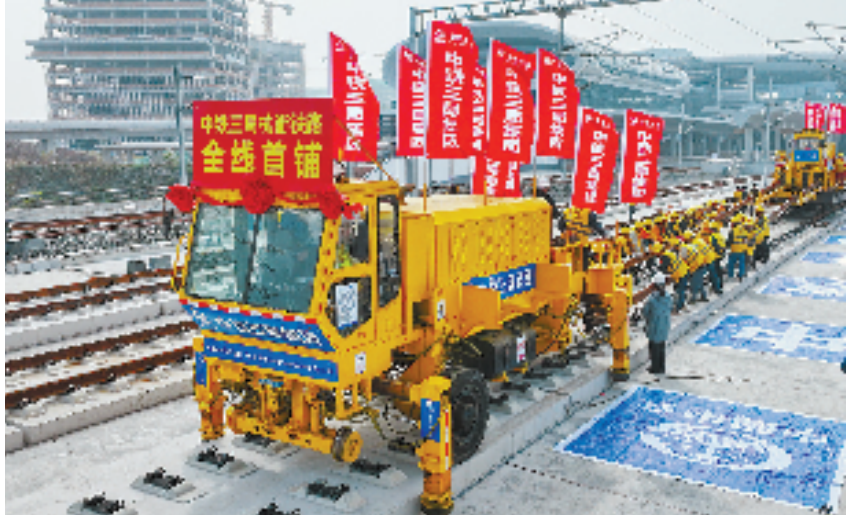
图为铺轨现场。
