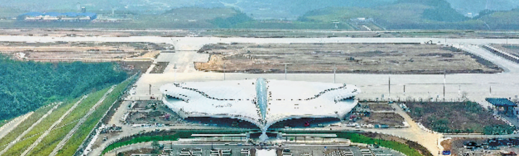
10月24日,丽水机场跑道全线贯通。图为空中俯瞰正在建设的丽水机场。
