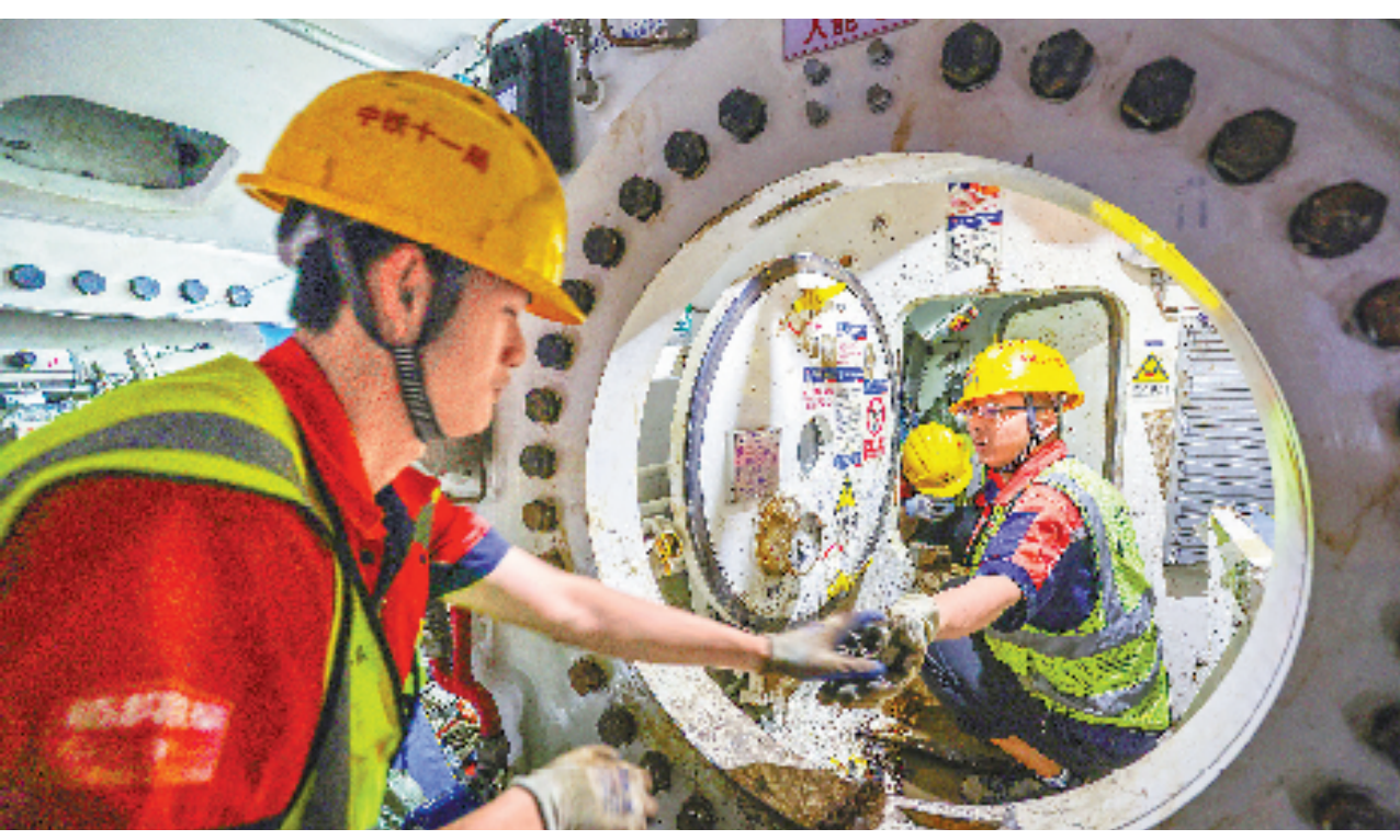
10月2日，施工团队在地下深处为“定海号”盾构机更换刀具。
