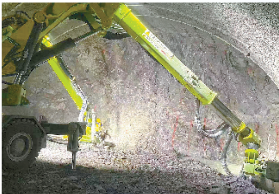
隧道钻爆法掘进采用多臂岩机现场钻孔作业
