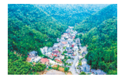
旧貌换新颜（图片由杭州市余杭区住房和城乡建设局提供）
