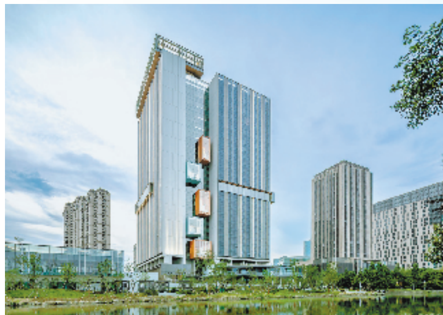
北仑青年创业创新大厦保障性租赁住房项目外景
