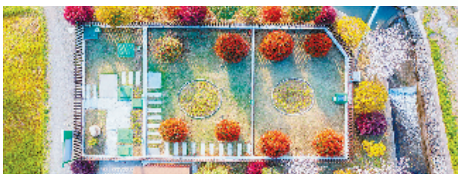
象山县农村污水处理终端现场实景
