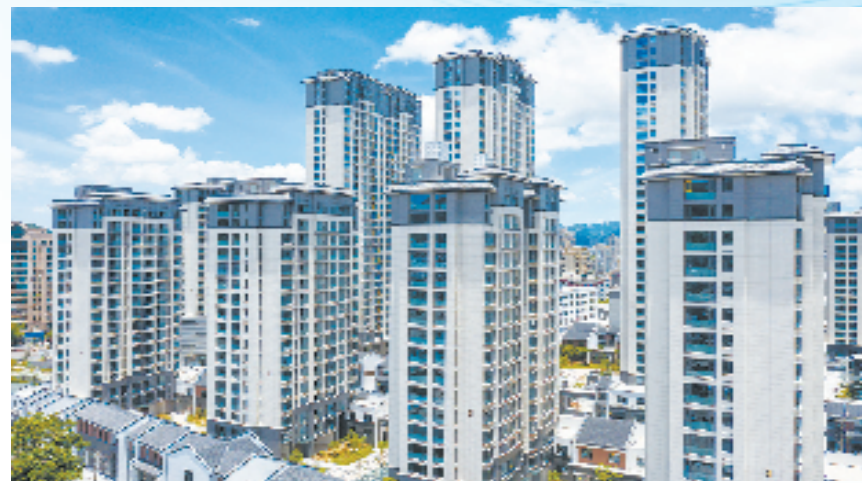
改造后的坊巷里小区 徐伟杰 摄
