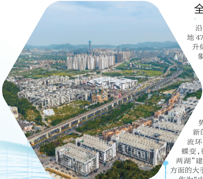
横峰街道全域整治产业园 沈益峰 摄
