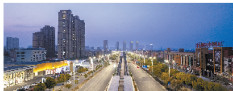
金华东阳市区路灯节能改造示范项目 国网(金华)综合能源服务有限公司供图
