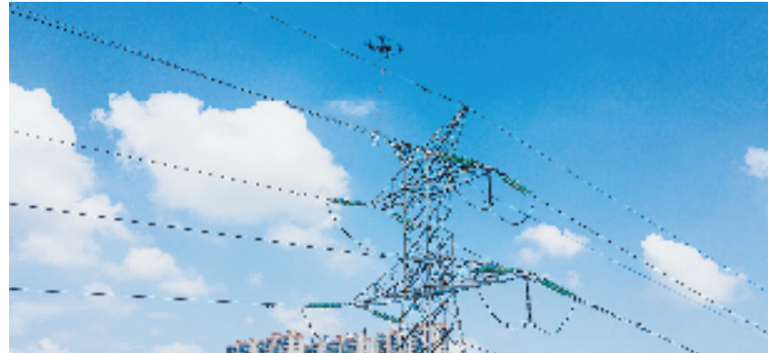
无人机将“新生代”X光检测机器人吊至地线接续管处(图片由国网湖州供电公司提供)
