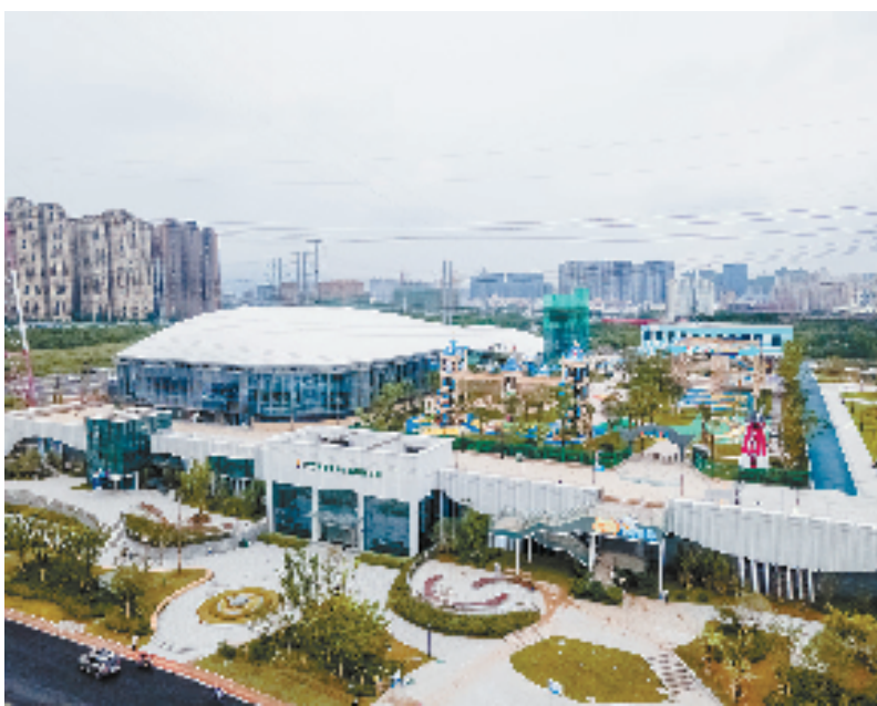
温州市中心片污水处理厂全景图
