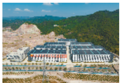
莲都义乌合作共建的专精特新产业园项目
