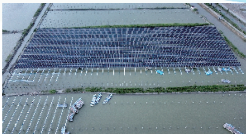
登步岛“渔光互补”项目施工现场
