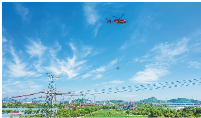
直升机带电作业 (图片由国网湖州供电公司提供)
