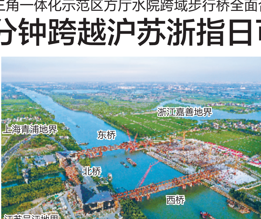
8月8日,长三角一体化示范区方厅水院施工现场热火朝天。本报记者 王志杰 彭鹏 摄
