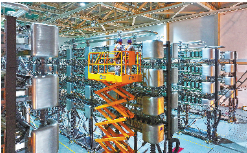
检修师傅站在曲臂车上检修绝缘子。
