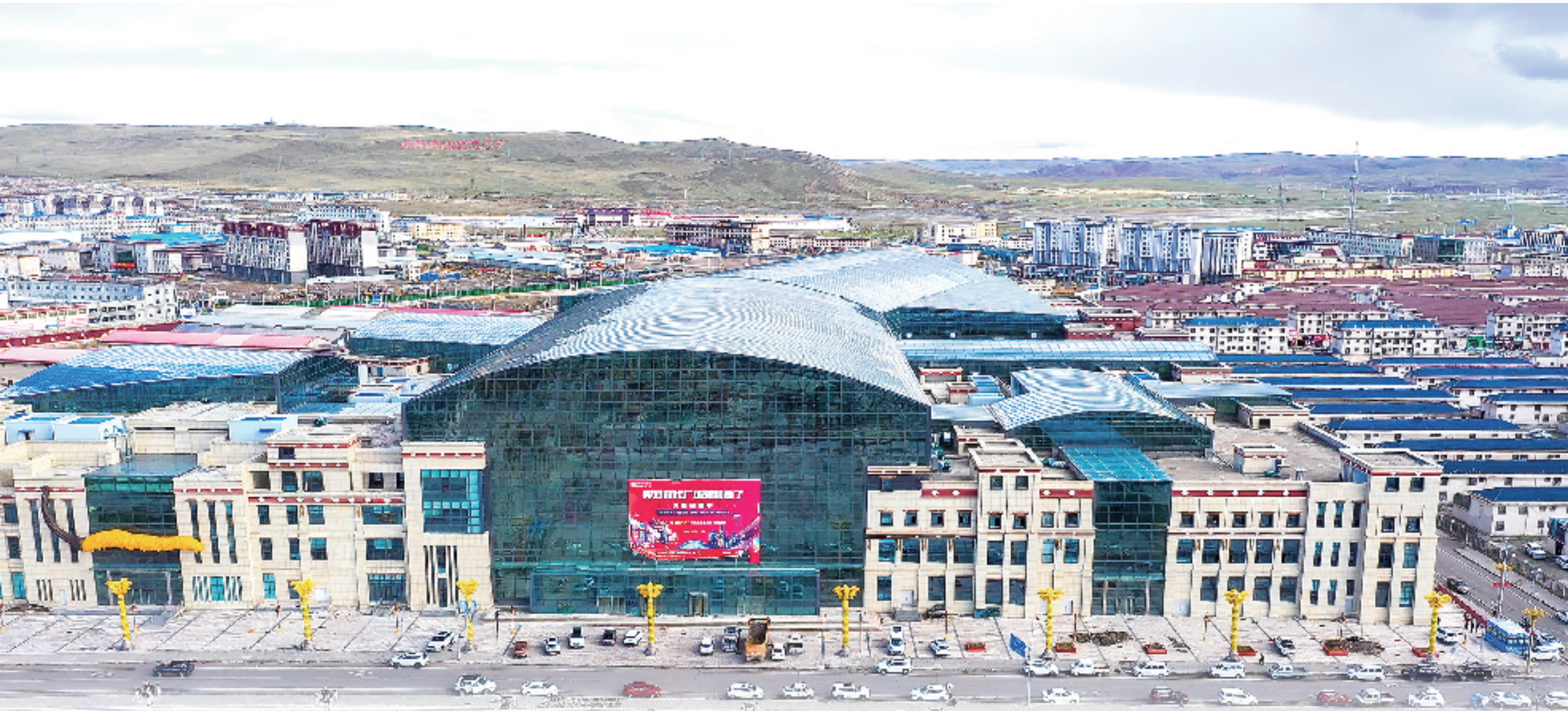
2023年6月,西藏神力集团投资8000万元,在那曲建设规模最大的多功能商业中心,将是那曲市生态精品智慧城市标志性项目。
