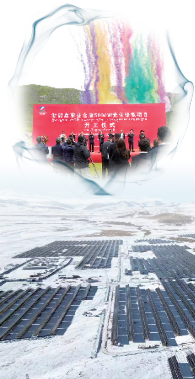
2023年11月,浙江省能源集团仅用70天,在那曲海拔4700米的高寒缺氧地带建成50MW光伏储能电站。
