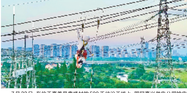
7月22日,在位于嘉善县鑫峰村的500千伏汾汾线上,国网嘉兴供电公司输电带电作业人员穿戴着密不透风的全套屏蔽服,有序开展超高压线路带电消除缺陷作业,保障电网迎峰度夏。 本报记者 王志杰 拍友 凌汝晨 陈捷
