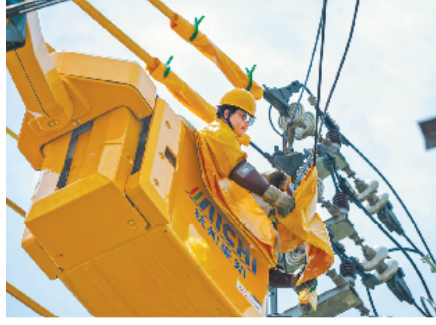
烈日下,国网苍南县供电公司带电作业中心工作人员正在紧张作业。
