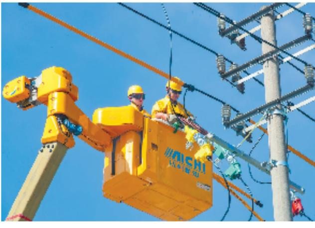
7月8日,湖州市长兴县雉城街道长新路,供电工人正在10千伏下沿线开展带电搭接分支引线工作。当天,长兴县最高温度达39℃,国网长兴县供电公司带电作业人员冒着高温加快开展带电搭接分支引线工作,整个作业过程用户“零感知”,为迎峰度夏打下坚实基础。王徐超
